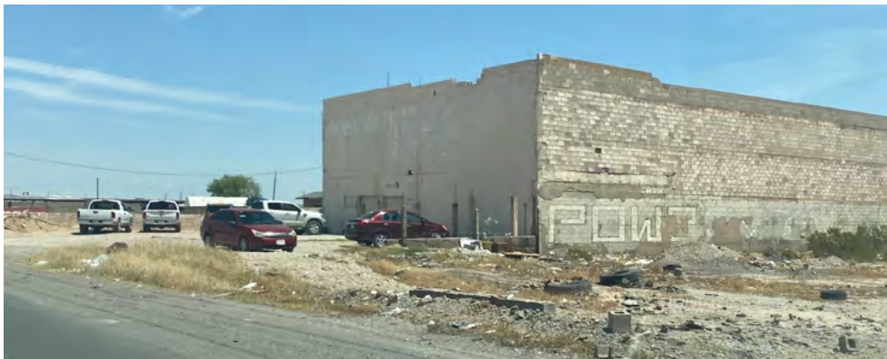
■ FIGURA 13. Terreno baldío sin banqueta, barda y con edificaciones en ruinas
